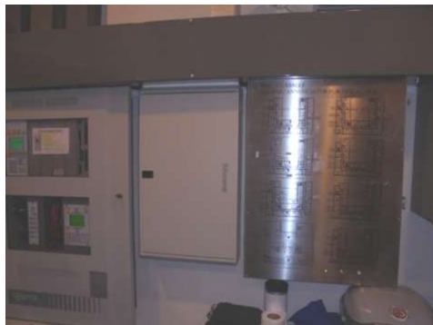
ภาพที่ 4-28 อุปกรณ์แจ้งเหตุอัคคีภัยและศูนย์รับแจ้งเหตุเพลิงไหม้
