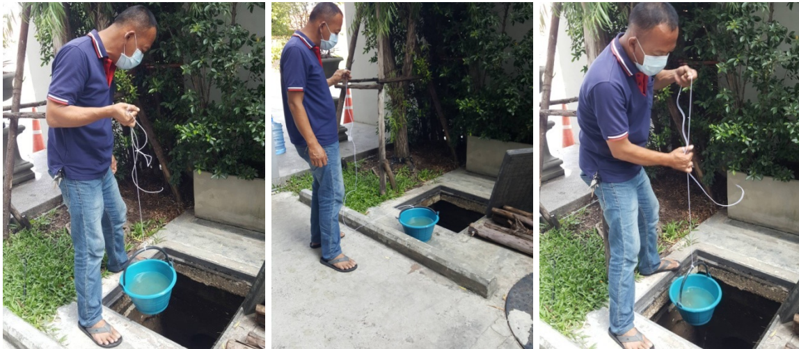
ภาพที่ 4-38 ทำความสะอาดบ่อพักน้ำที่ระบายน้ำทิ้ง
