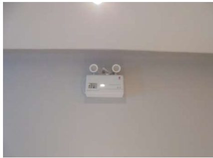
ภาพที่ 4-27 ไฟฟ้าส่องสว่างฉุกเฉิน
