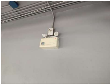
ภาพที่ 4-27 ไฟฟ้าส่องสว่างฉุกเฉิน
